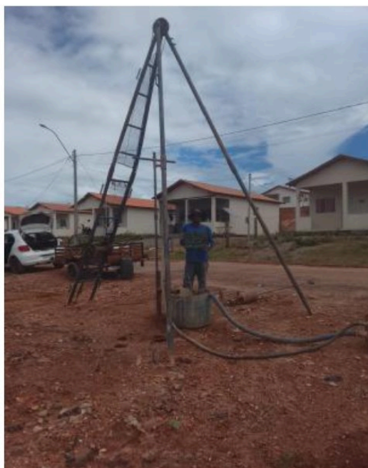
FOTO 02 - EXECUÇÃO DE FURO SONDAGEM A PERCUSSÃO
