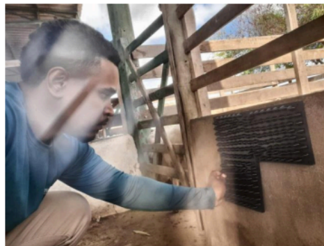
Figura 2A - Instalação de superfície texturizada na baia experimental.
