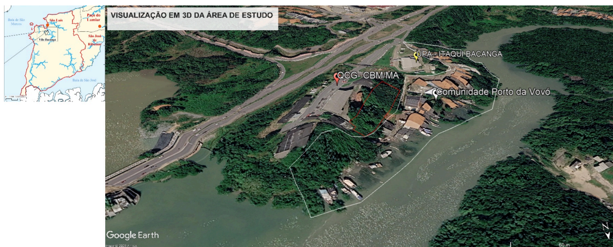
Figura 2. Encosta localizada na comunidade Porto da Vovó
