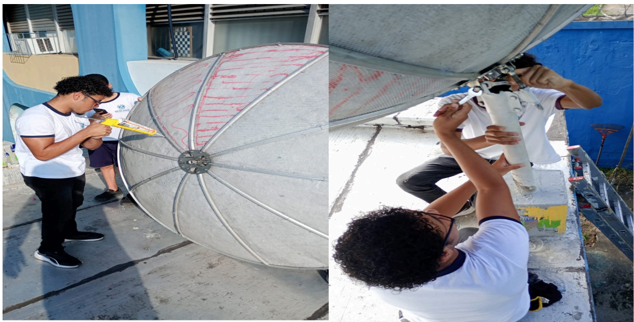
Figura 22. Preparo e Instalação da parábola do concentrador parabólico.
