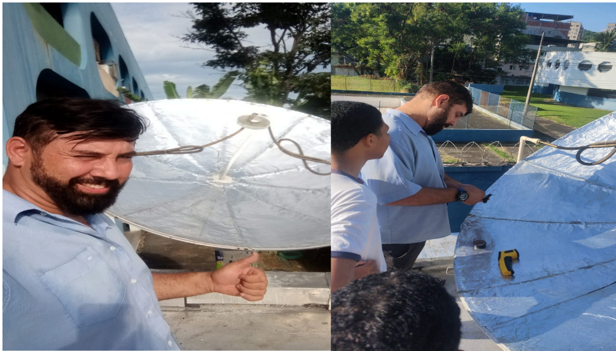
Figura 23. Instalação dos sensores no sistema.
