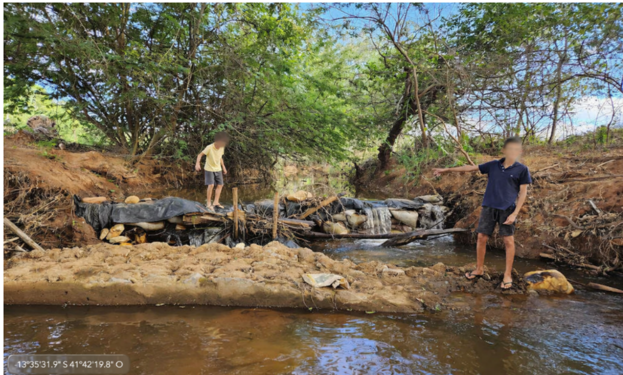
Figura 3. Açudamento com sacos de areia após rompimento da alvenaria
