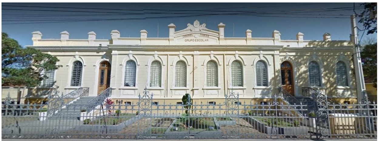
Figura 3. Edifício do Grupo Escolar Coronel Tobias
