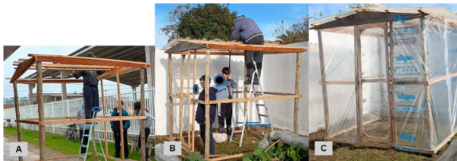
Figura 3. Construção da estufa para acondicionamento das mudas.
