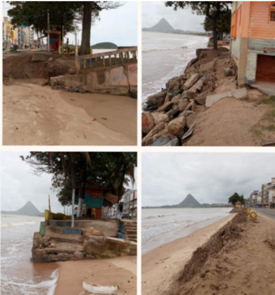
Figura 3 - Estado erosivo da orla de Piúma durante o ano de 2023. Fonte: Autor.
