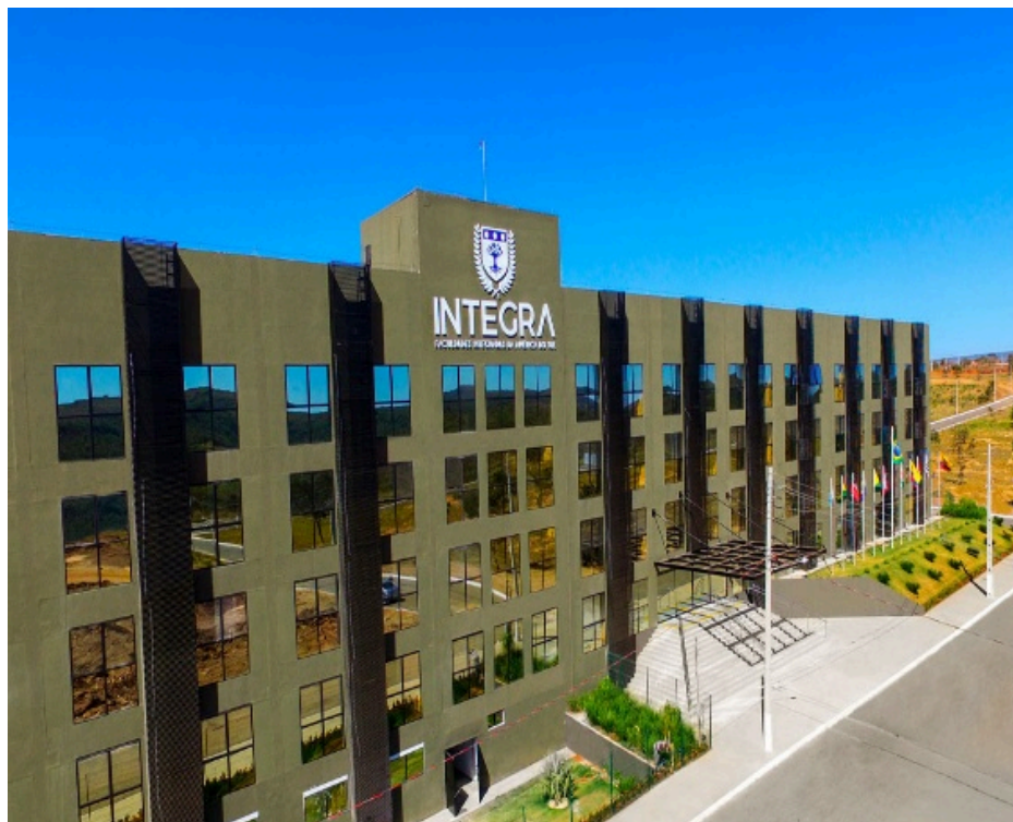
Figura 4: Foto Bloco Principal Faculdade Integra
