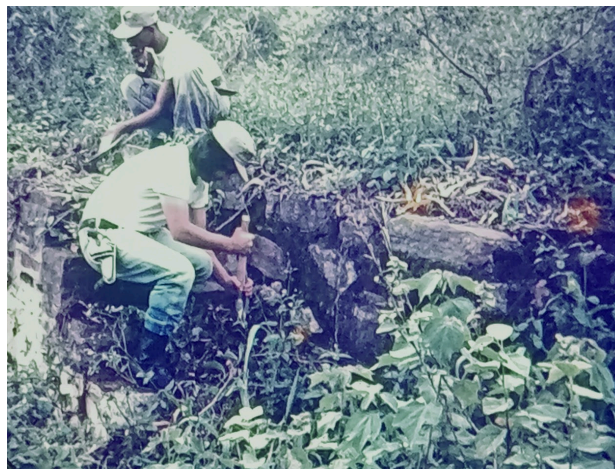
Figura 11. Estrutura de alicerce e escada de construção doméstica.
