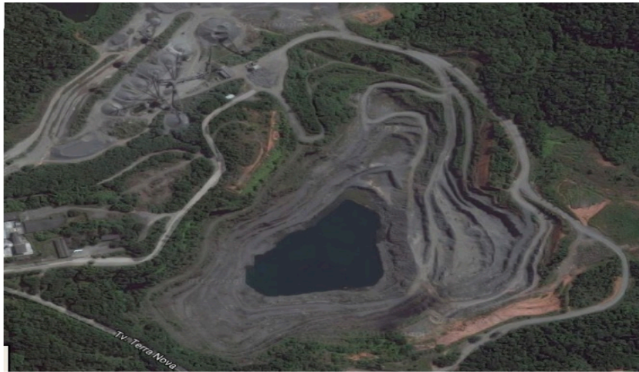
Extração de Agregados – Região Metropolitana de Salvador (Fonte: Google Maps)
