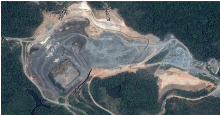
Extração de Agregados – Região Metropolitana de Salvador (Fonte: Google Maps)
