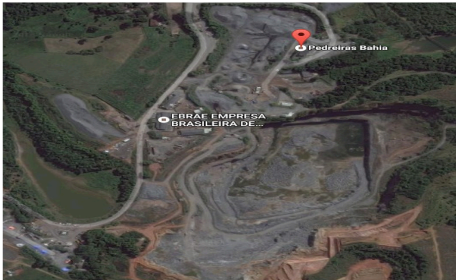
Extração de Agregados – Região Metropolitana de Salvador (Fonte: Google Maps)
