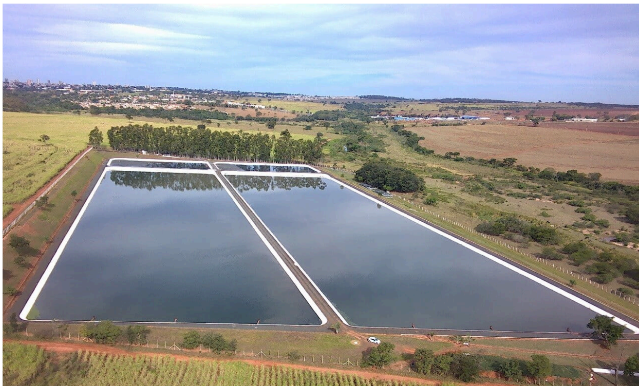
Figura 1. Visão geral da Estação de Tratamento de Esgotos (ETE) de Fernandópolis-SP.
